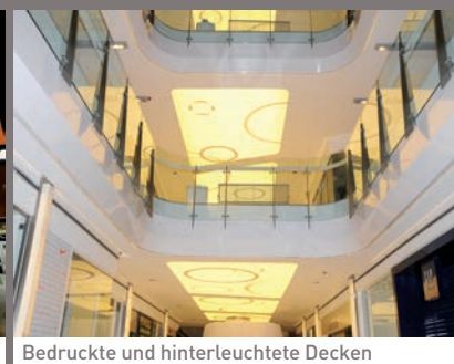
Bedruckte und hinterleuchtete Decken
